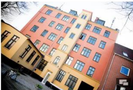
Elevatoren er installeret i det gamle trappetårn, så bygningens arkitektoniske udtryk er bevaret. På udsigten er det set ikke til at se, at der gemmer sig en teknisk, ny elevator bag døren. Foto: Kristoffer Joel Poulsen
