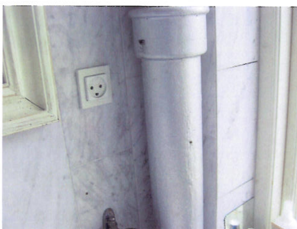
Billede 16: Tæring på faldstamme i badeværelse.
