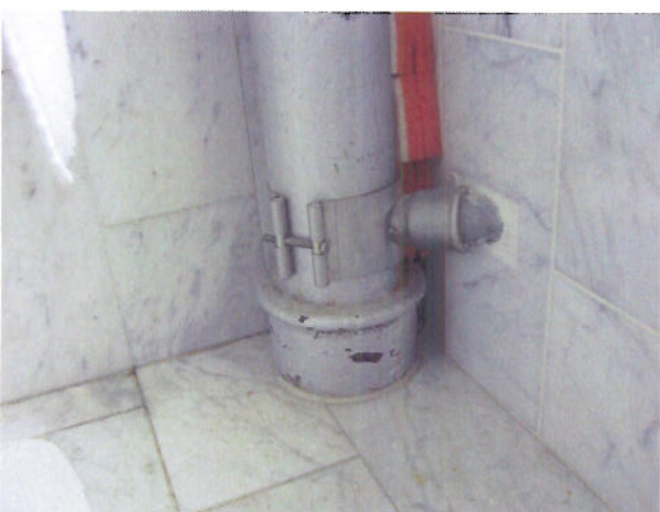
Billede 17: Tæring på faldstamme i badeværelse.
