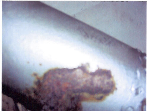
Billede 2: Tæret faldstamme i kælder.
